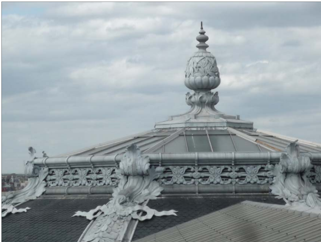
Vue rotonde octogonale du Palais d'Antin avec décors zinc estampillé © Francois Chatillon, Architecte ACMH
