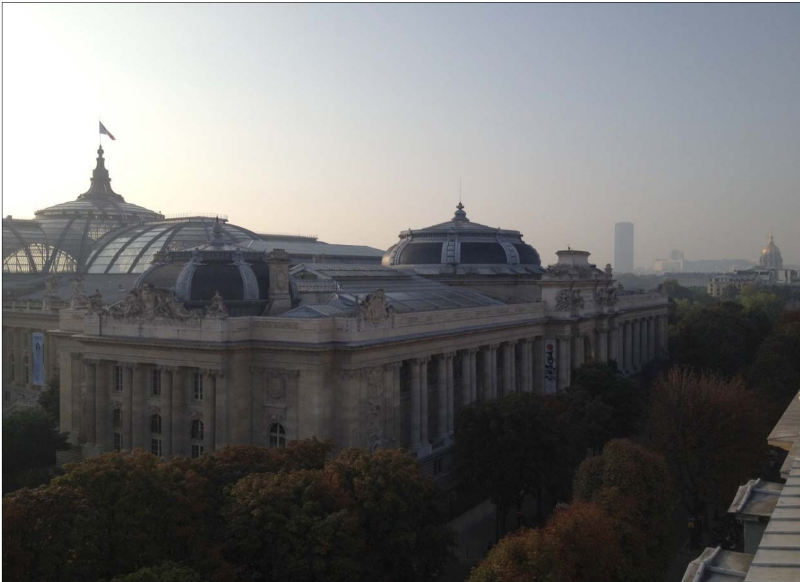
Vue ensemble du Grand Palais, Palais d'Antin au premier plan © Francois Chatillon, ACMH
